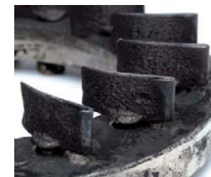
FOT. 14. USZKODZONE KIEROWNICE POWIETRZA W ZESPOLE VTG
