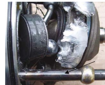
ZESPÓŁ OBROTOWY SPRĘŻARKI UKŁADU KLIMATYZACJI ZNISZCZONY Z POWODU BRAKU SMAROWANIA W TRAKCIE ROZRUCHU. SZCZEGÓLNĄ UWAGĘ ZWRACA BRĄZOWO-NIEBIESKI KOLOR CZĘŚCI, KTÓRE ULEGŁY PRZEGRZANIU I ZATARCIU. POWODUJĄC KATASTROFALNĄ W SKUTKACH USTERKĘ
