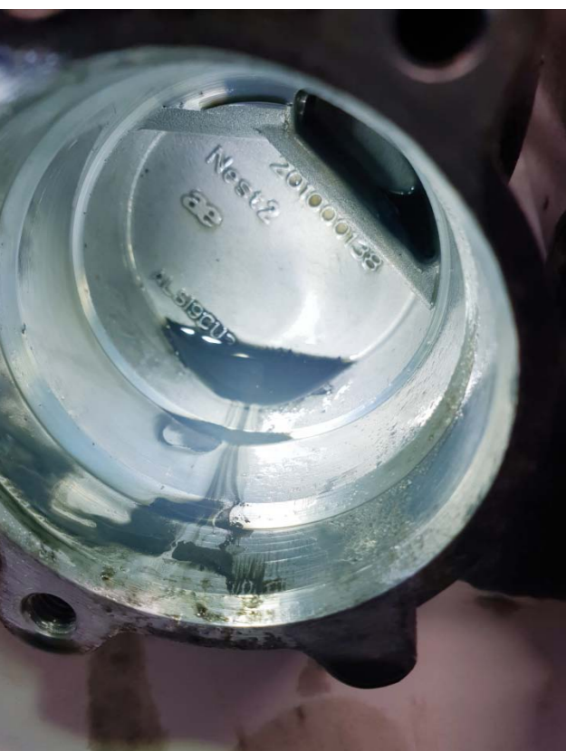
ZANIECZYSZCZENIA ZNAJDUJĄCE SIĘ WEWNĄTRZ SKRZYNI ROZDZIELCZEJ
