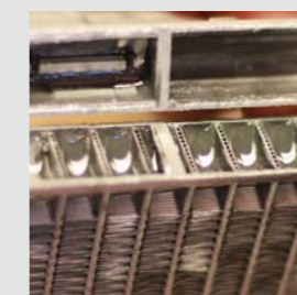
Czarny, zwęglony olej blokujący rurki skraplacza
