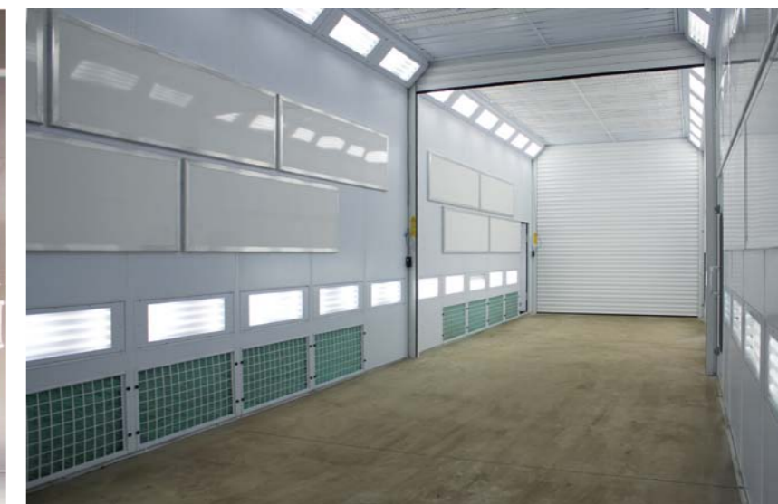
WNĘTRZE KABIN Z POZIOMO ZAMOCOWANYMI PANELAMI ENDOTERMICZNYMI
