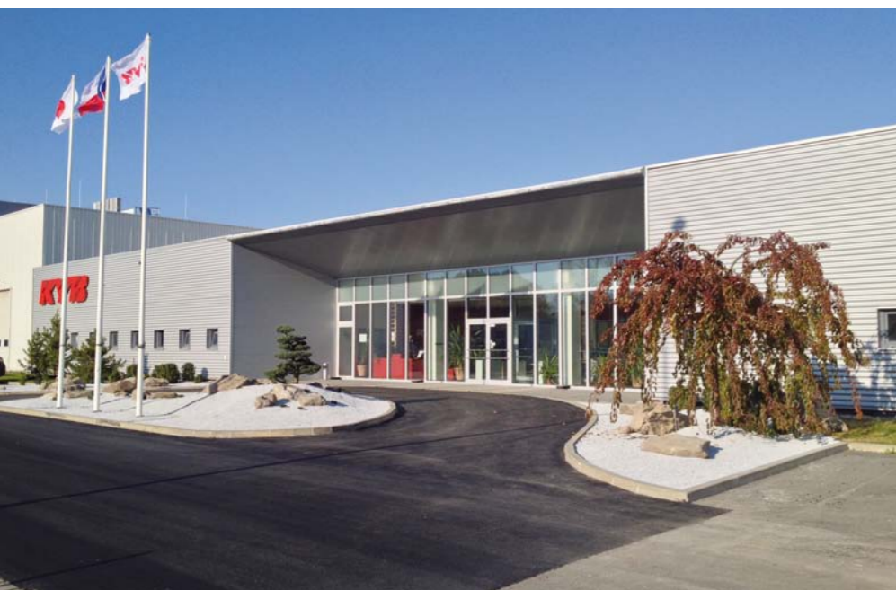
GLÓWNE WEJŚCIE DO ZAKŁADÓW KYB MANUFACTURING CZECH (KMCZ) W PARDUBICACH
