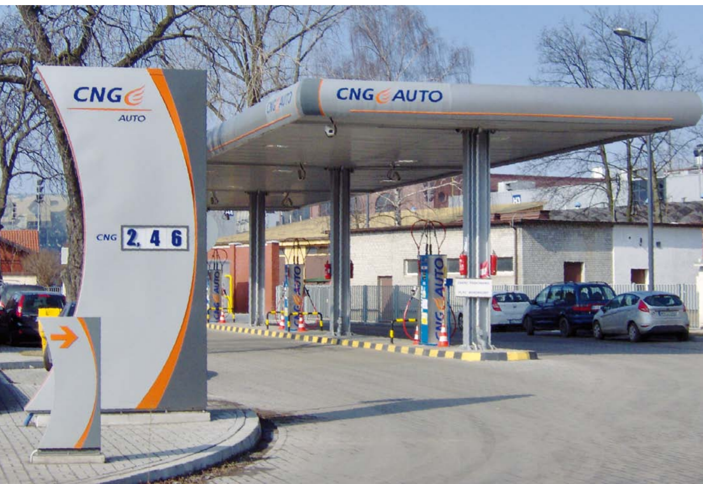
PUBLICZNA, KOMERCYJNA STACJA TANKOWANIA CNG W WARSZAWIE
