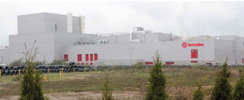
FABRYKA TARCZ HAMULCOWYCH BREMBO W DĄBROWIE GÓRNICZEJ – HALA PIECÓW INDUKCYJNYCH
