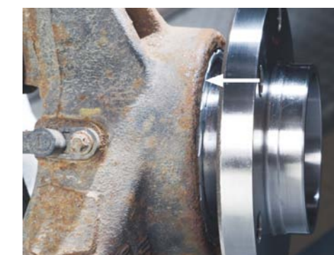
PRZYCYNĄ NADMIERNEGO OPORU PRZY WYKONYWANIU POŁĄCZENIA WCISKOWEGO JEST ZWYKLE KOROZJA GŁADZI W ODKUWCE ZWRÓTNICY LUB ZADZIORY SPOWODOWANE WCZEŚNIEJSZYMI BŁĘDAMI MONTAŻOWYMI
