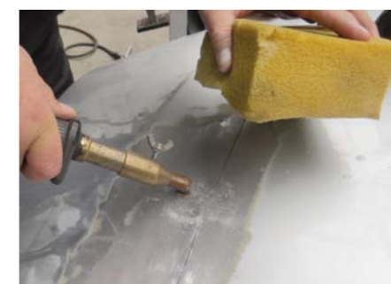
PROSTOWANE MIEJSCE NATYCHMIAST PO ROZGRZANIU CHŁODZONE JEST ZIMNĄ WODĄ WYCISKANĄ Z GĄBKII
