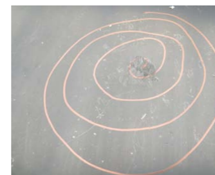
ORIENTACYJNA LINIA WYZNACZAJĄCA MIEJSCE I KOLEJNOŚĆ UDERZEŃ MŁOTKA PRZY LIKWIDACJI WGNIECENIA
