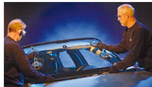
DEMONTAŻ I MONTAŻ SZYB WYMAGA UŻYCIA PODCIŚNIENIOWYCH UCHWYTÓW
