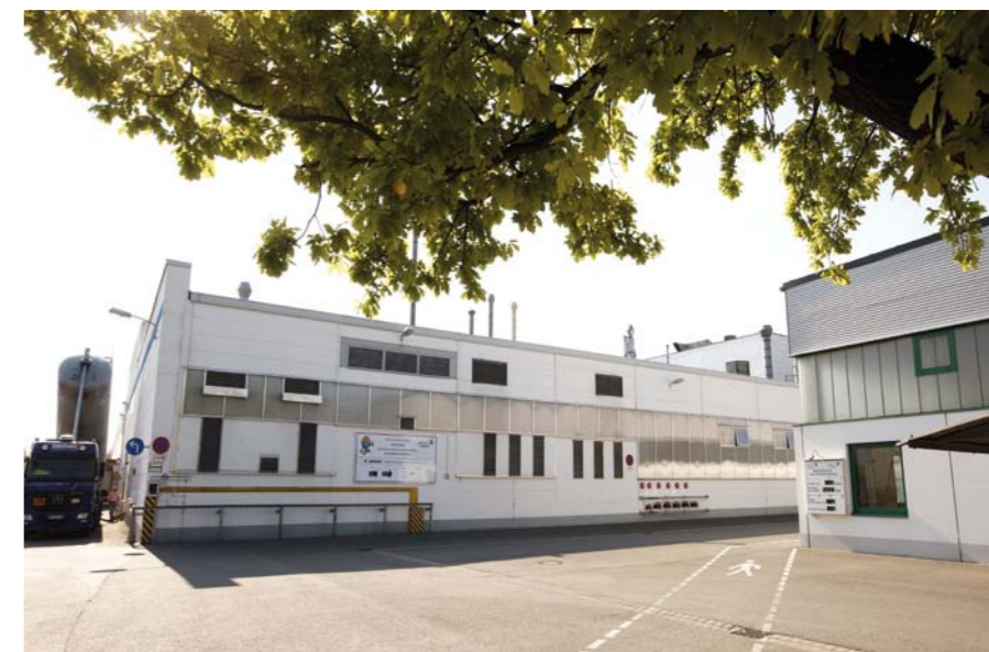
MODERNIZOWANA I ROZBUDOWYWANA FABRYKA AKUMULATORÓW AGM W ZWICKAU
