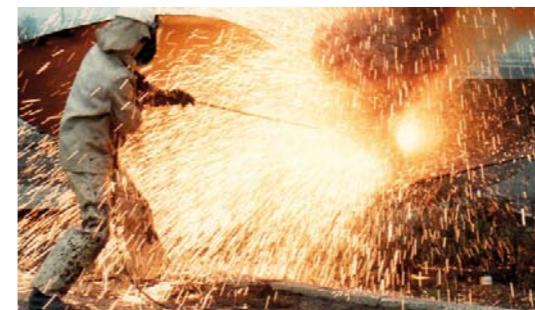
CIĘCIE LANCĄ TLENOWĄ
