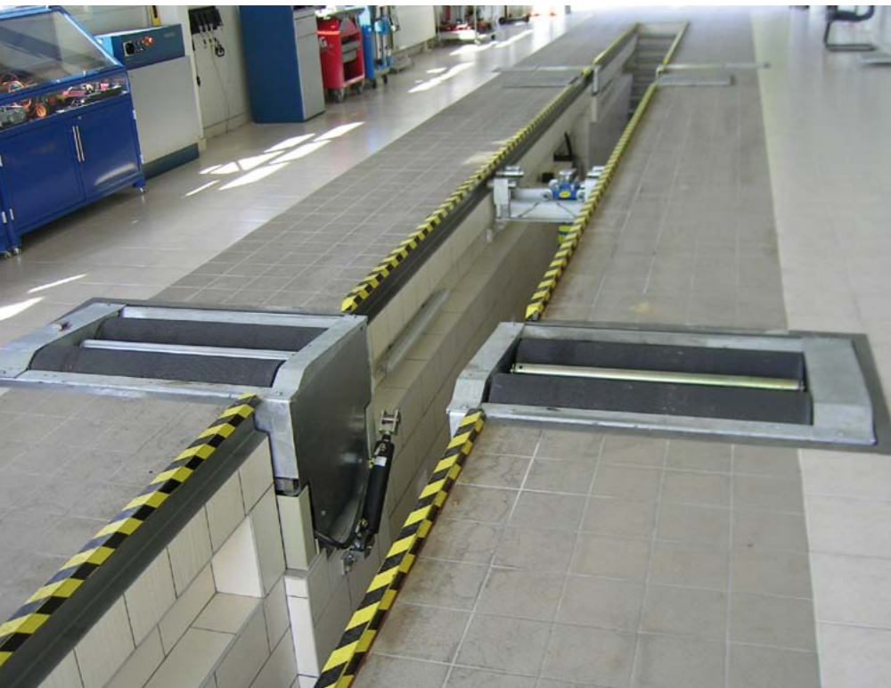
KANAL REWIZYJNY STACJI KONTROLI POJAZDÓW
