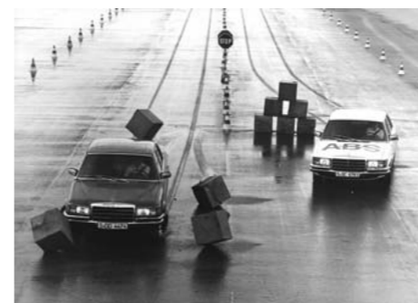
TEST PORÓWNAWCZY HAMOWANIA SAMOCHODU Z ABS (Z PRAWYJ) I BEZ TEGO SYSTEMU PRZEPROWADZONY W KOŃCU LAT 70. XX WIEKU
