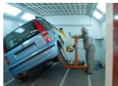
PO ZAKOŃCZENIU APLIKACJI LAKIERU PODNOŚNIK DAJE SIĘ ŁATWO USUNĄĆ Z KABINY
