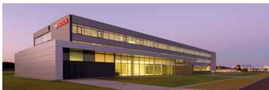
NOWA SIEDZIBA ROBERT BOSCH SP. Z O.O. Z CENTRAMI BIUROWYMI I SZKOLENIOWYMI
