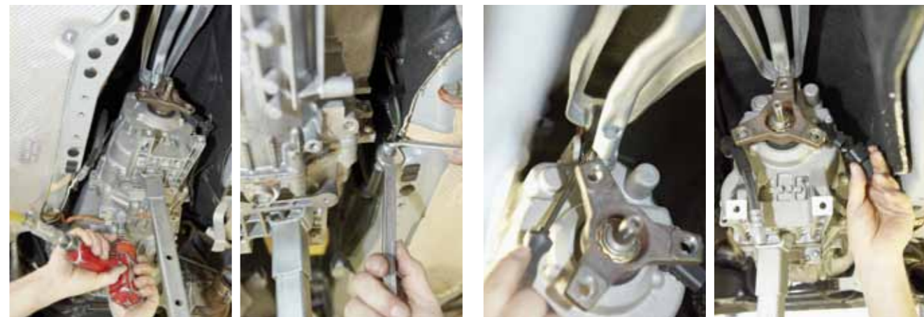
FOT. 1. ODŁĄCZANIE PASKA UZIEMIĄCEGO ORAZ PRZEWODU HYDRAULICZNEGO WYSPRĘGLIKA CSC
