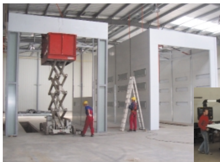
Montaż kabin Astherm wykonanych dla konkretnego klienta
