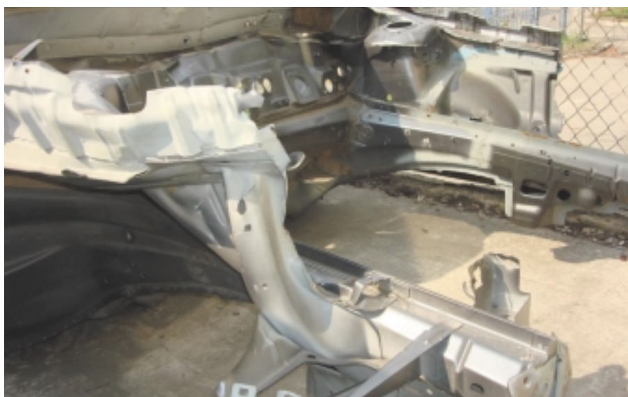
Nadkola, gniazda kolumn McPhersona i przegrody przednie tworzą zwarty węzeł odkształcający się wspólnie podczas kolizji drogowych
