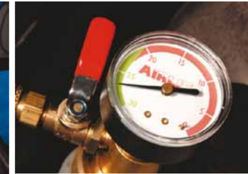
Test szczelności układu chłodzenia. Po prawej: wytwarzanie podciśnienia, u góry: śledzenie manometru przy zamkniętych zaworach
