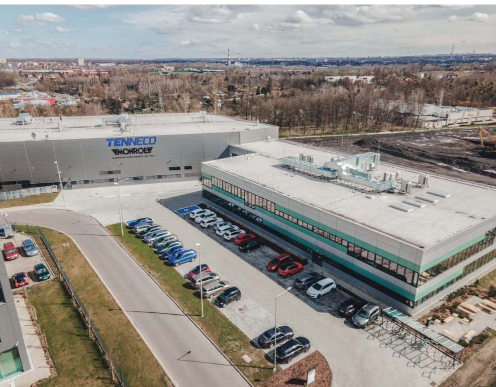
CENTRUM INŻYNIERYJNE MONROE JEST ZLOKALIZOWANE W KOMPLEKSIE „NOWE GLIWICE” NA TERENIE, GDZIE ĆWIERĆ WIEKU TEMU DZIAŁAŁA KOPALNIA WĘGLA KAMIENNEGO
