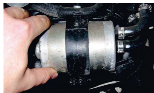
RYS. 6. KORYZJA NA SKUTEK USZKODZONEJ IZOLACJI
