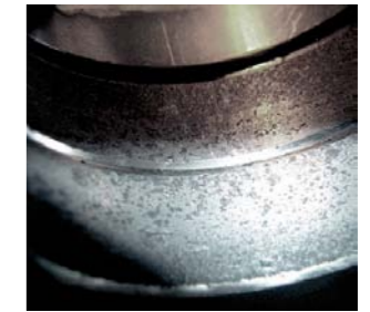
FOT. 12. WŻERY KOROZYJNE W POWIĘKSZENIU
