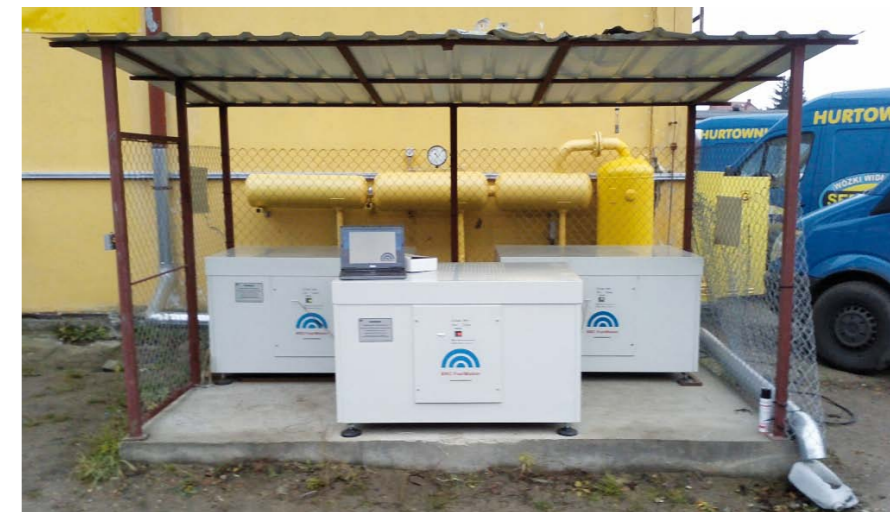
ZINTEGROWANY ZESPÓŁ DUŻYCH SPRĘŻAREK BIG Q FMQ10 Z OFERTY BRC FUELMAKER
