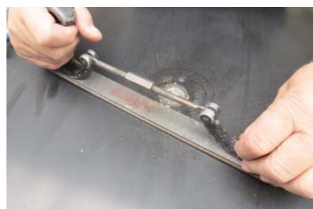
PILNIK BLACHARSKI WYGŁADZA WYPROSTOWANĄ POWIERZCHNIĘ, USUWAJĄC JEJ WYPUKŁOŚCI I UJAWNIAJĄC WKŁĘŚŁOŚCI
