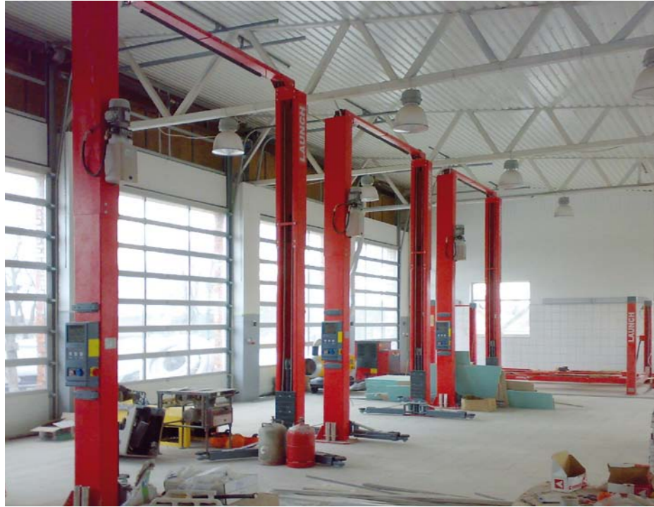
HALE WARSZTATOWE O KONSTRUKCJI MODUŁOWEJ SĄ ZNACZNIE TAŃSZE OD BUDOWANYCH TRADYCYJNIE I POWSTAJĄ W CZASIE WIELOKROTNIE KRÓTSZYM
