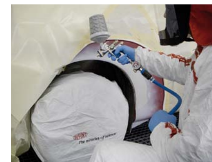
APLIKACJA PODKŁADU WYTRAWIAJĄCEGO JAKO PIERWSZEJ WARSTWY NOWEJ POWŁOKI
