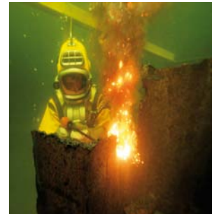
CIĘCIE LANCĄ POD WODĄ
