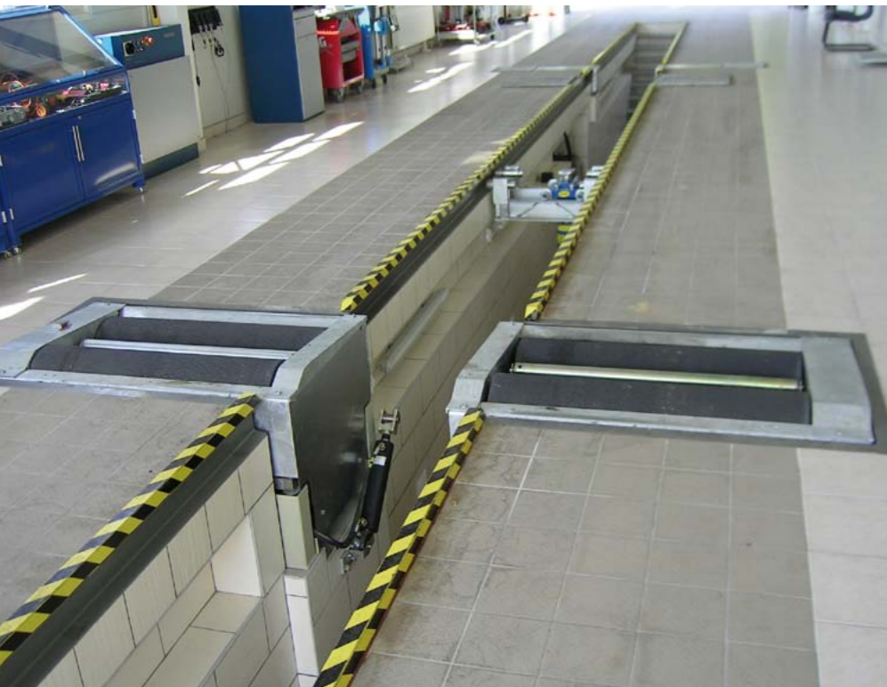
KANAL REWIZYJNY STACJI KONTROLI POJAZDÓW
