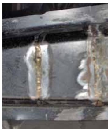
Spód spoiny wykonanej metodą lutowania. Z lewej: prawidłowy, z prawej: nieregularny
