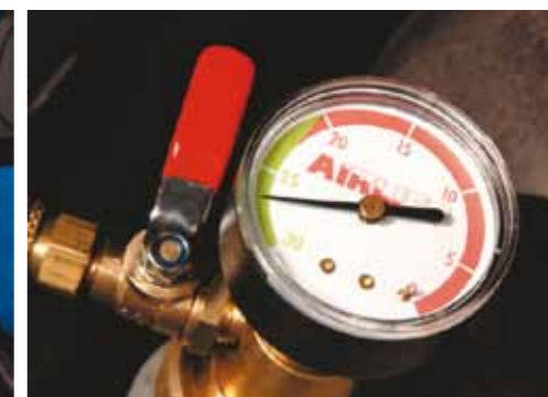
Test szczelności układu chłodzenia. Po prawej: wytwarzanie podciśnienia, u góry: śledzenie manometru przy zamkniętych zaworach
