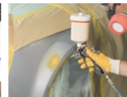
Gruntowanie odsłoniętych powierzchni metalu
